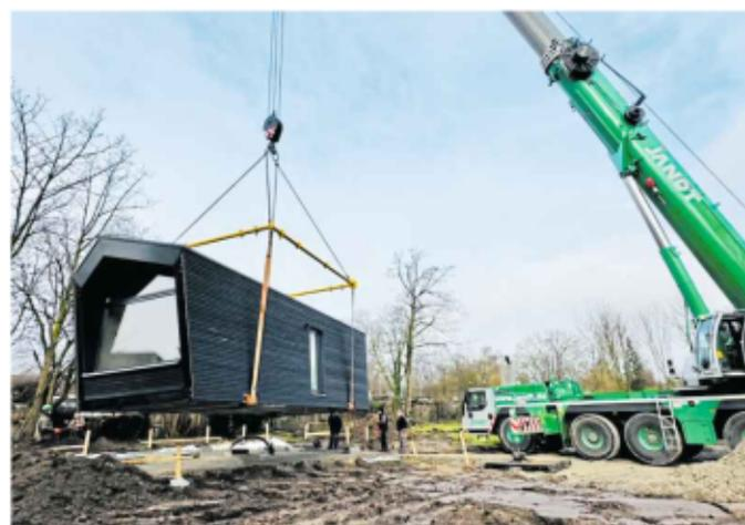
Der erste Teil des Tiny-Houses schwebt ein an der Traverse des Krans und absolviert eine Punktlandung.
