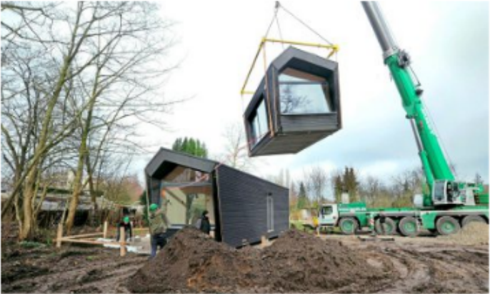
Haus am Kran: Die beiden Module wurden in Wetzlar produziert und am Dienstag fast bezugsfertig in Bielefeld angeliefert.
