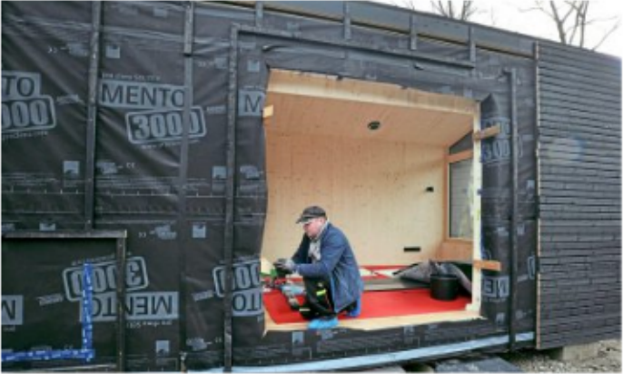
Der Durchgang zur Küche, die als zweites Modul geliefert wird, wird für die Montage vorbereitet.
