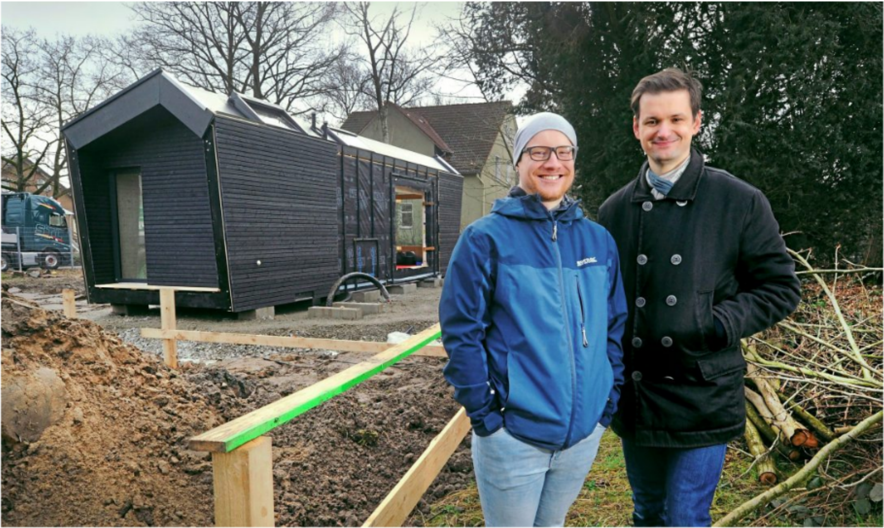
Schon in Kürze können Jan (links) und Dominic Hallau ihr Frühstück im neuen Eigenheim genießen. Ihr Tiny House ist das erste Gebäude der neuen Siedlung an der Heeper Straße. Fotos: Bernhard Pierel
