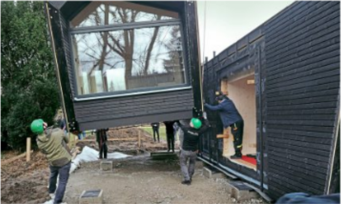
Maßarbeit: Die Küche wird millimetergenau platziert und mit dem Hauptgebäude verbunden. Gut zu sehen sind die Betonpunkte, auf die die beiden Module gesetzt werden.
